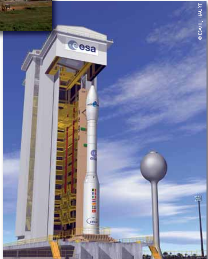
Le portique mobile de Vega. Combinant les activités "BIL/BAF", il se retirera du pas de tir pour découvrir le lanceur peu avant son décollage.
