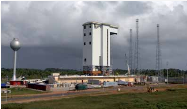
Le chantier Vega en avril 2008
